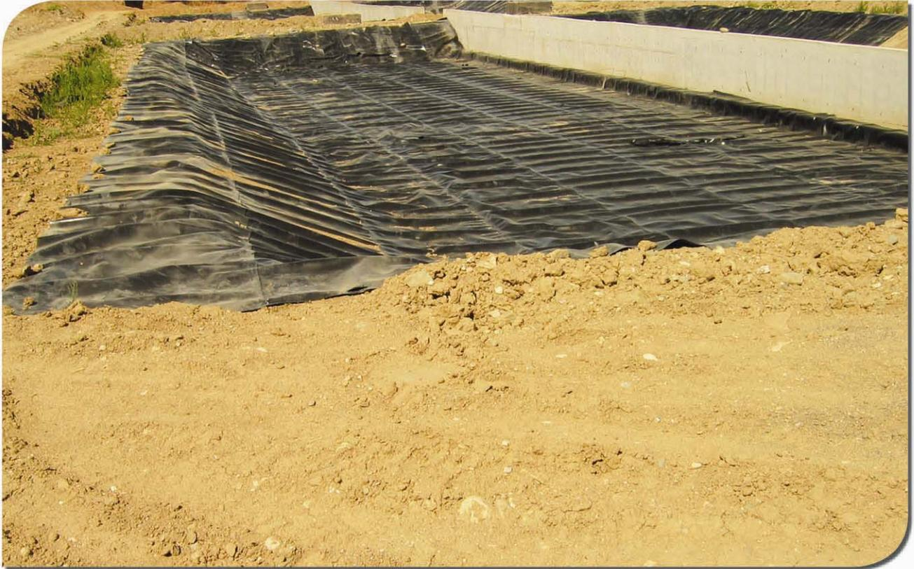
HDPE yüksek yoğunluklu polietilen, LLDPE düşük yoğunluklu polietilen anlamına gelmektedir. Kullanılacağı yere göre girintiler ve çıkıntılar fazla ise LLDPE, daha düz detaylar mevcut ise HDPE membran seçilmelidir.
