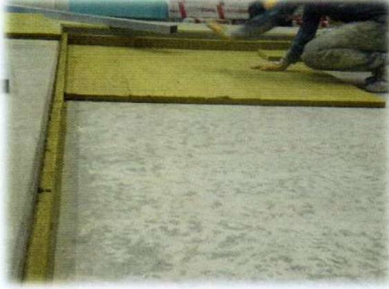
i)30/150 Terrawool döşemeye yerleştirilirken
