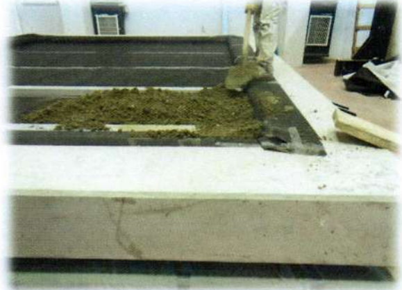
iv)Şap betonu yerleştirilmesi
