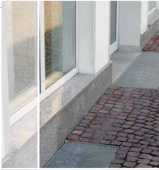
İşık Bacası 125x100, ilave kapak, derinlik 60 cm
